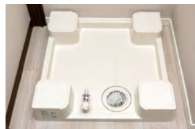
① 洗濯機防水パンの排水部のホース接続部を取り外します。
