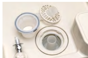
③ さらに内部の部品も取り外し、清掃します。
