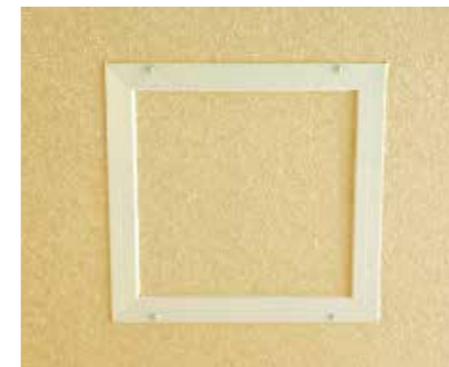
天井の点検口(例)
