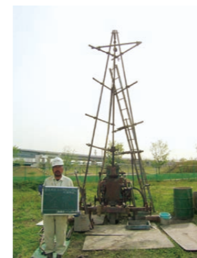
ボーリング調査(参考写真)
