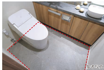
トイレ床タイル
