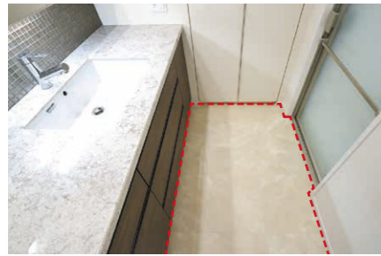
洗面室床タイル
