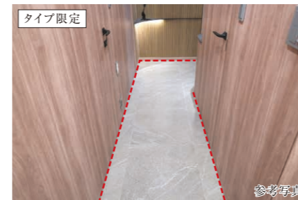
廊下床タイル
