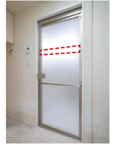
浴室扉タオルバー追加
