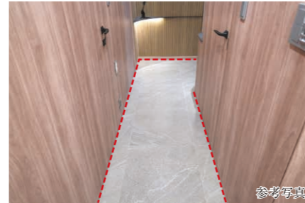
廊下床タイル
