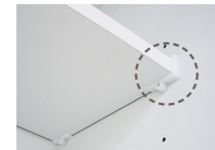
棚板脱落防止用ツメ(参考写真)
