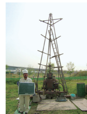
ボーリング調査(参考写真)
