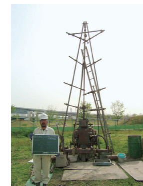
ボーリング調査(参考写真)
