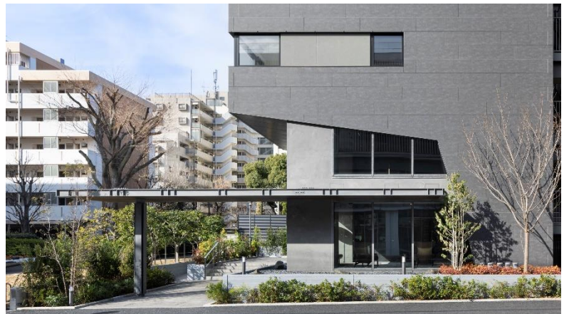
【来館者を迎え入れる鉄のエントランスゲート】
