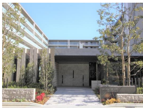
建物エントランス
